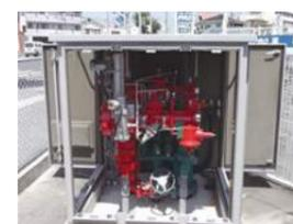
各地区の地震計のデータを速やかに収集し、被害が想定される地区についてはブロック単位でガスの供給を停止します。遠隔操作で速やかに供給停止できるガバナ遠隔遮断装置の設置を進めています。
